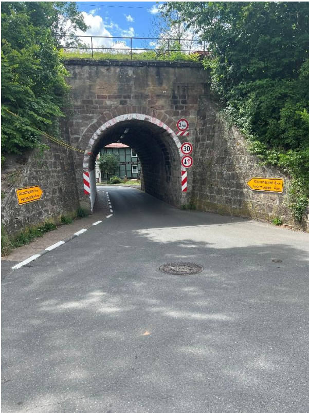
Bildunterschrift: Bahnviadukt Gertenbach, Stand: 14.08.2024
